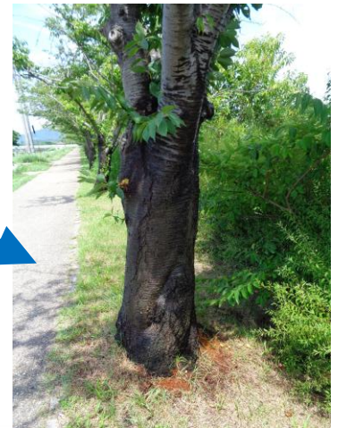
薬液のかかり状況
